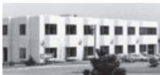
Завод Viessmann в Ватерлоо (Канада)
