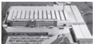
Завод Viessmann в Хоффе
