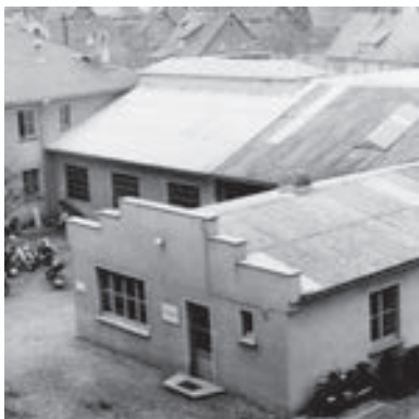
Заводской корпус в г. Аллендорфе
