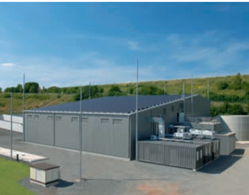
Биогазовая установка Viessmann
