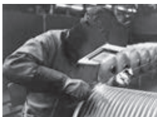
Сварка змеевиков накопителя
